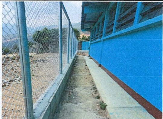
Foto 1: FINALIZACIÓN DE CERRAMIENTO PERIMETRAL EN SU TOTALIDAD.
