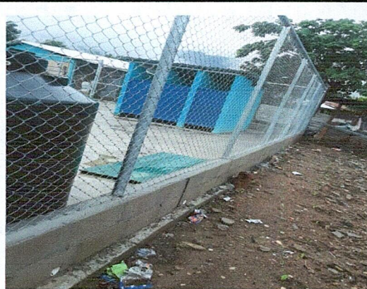
Foto 2: FINALIZACIÓN DE CERRAMIENTO PERIMETRAL
